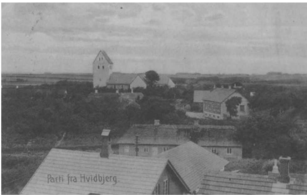
Det stråtækte hus er Krumborgvej 5 og er muligvis det eneste, der er tilbage af de i artiklen nævnte bygninger. Det store hus der ses lidt til højre er doktor Yhrs hus. (Foto: Thyholm Lokalarkiv.)
